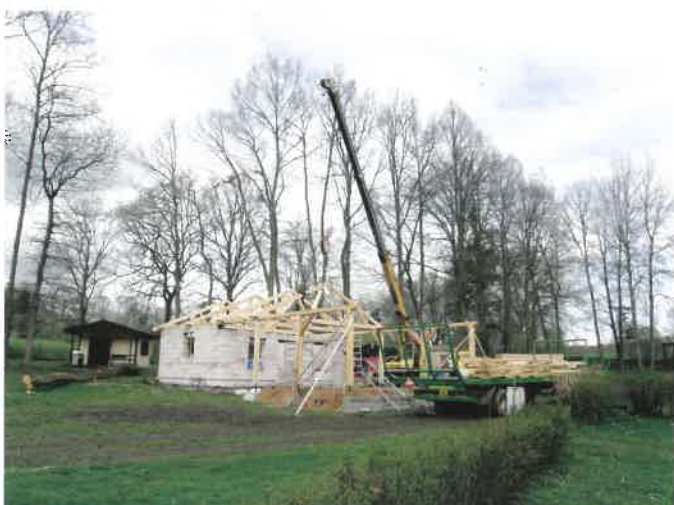
Stavba kuchyňky na koupališti. foto: V. Macoun
